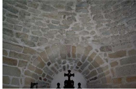
Photo 8 : changement de l'appareillage à la limite entre le mur et la voûte
